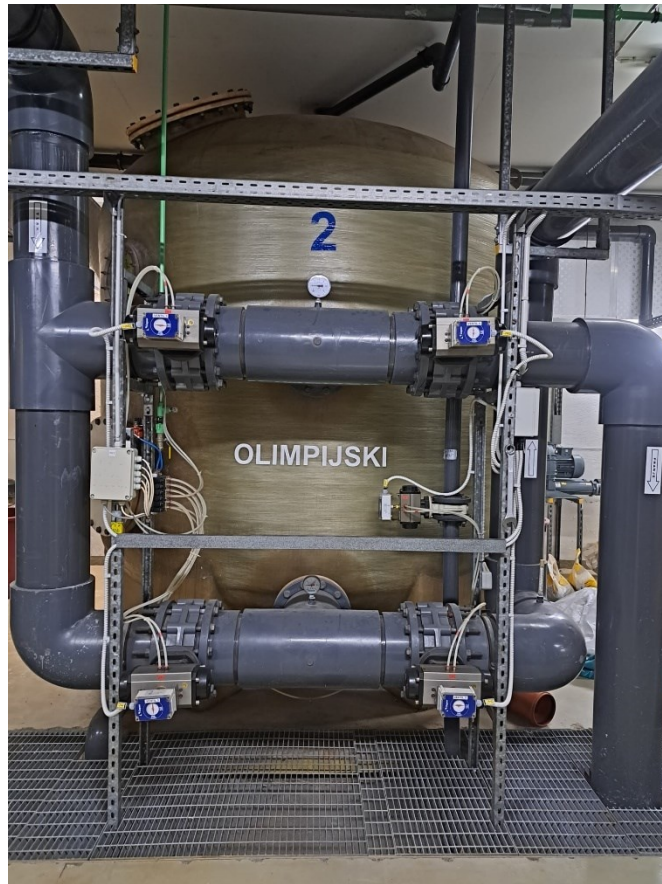
Slika 4 Sustav provođenja za bazen Izvor: privatna kolekcija
