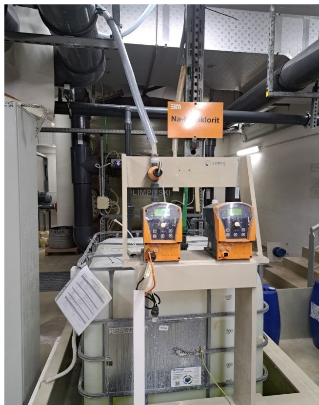
Slika 1. Na-hipoklorit za dezinfekciju bazenske vode Izvor: privatna kolekcija
