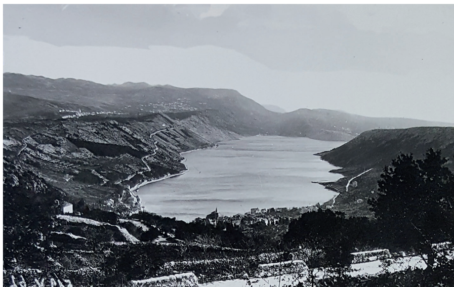
Slika 3. Pogled na Bakarski zaljev, početak šezdesetih godina 20. stoljeća. Grad Bakar na dnu zaljeva, a na platou iznad zaljeva naziru se naselja Krasica i Praputnjak (na slici lijevo), (Arhiva Konzervatorskog odjela u Rijeci)
