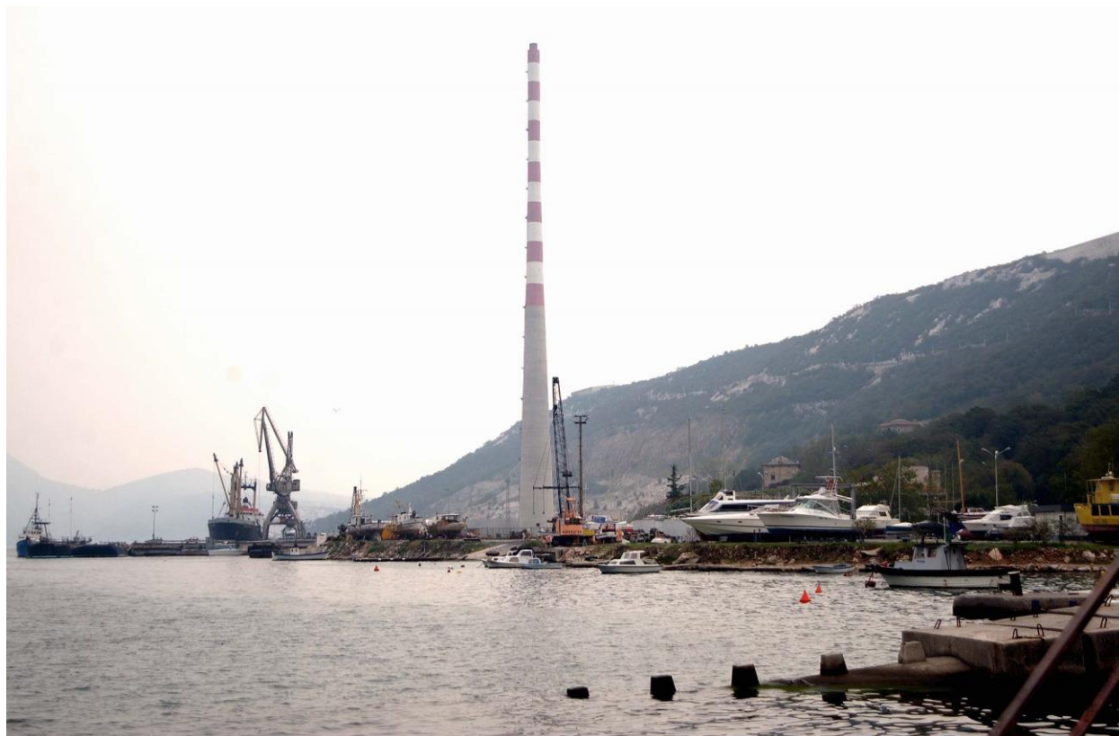
Slika 4. Dimnjak koksare u Bakru (preuzeto: https://www.novilist.hr/rijeka-regija/rijeka/bakru-otvorena-vrata-jaceg-razvoja-završen-likvidacijski-postupak-tvrtke-koksar-d-o-o/ )
