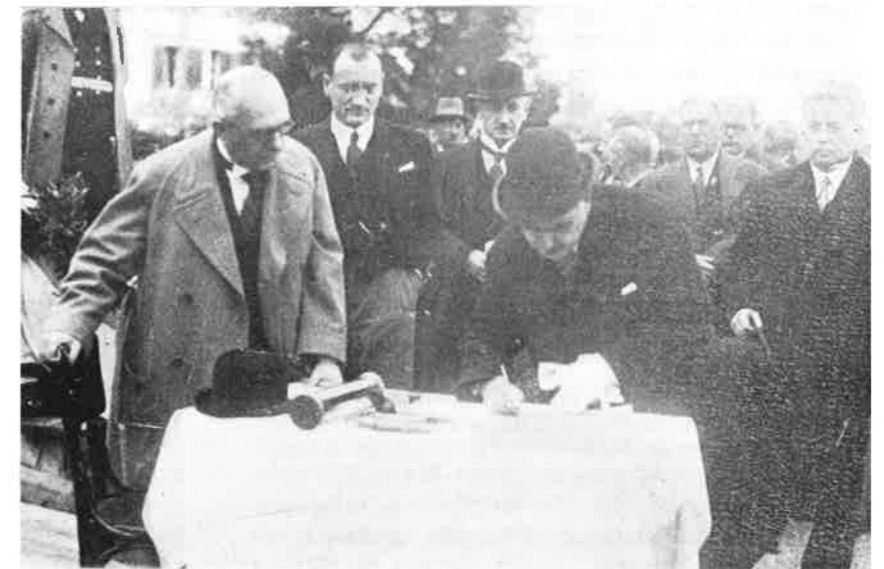
Prilikom potpisivanja povelje za vrijeme postavljanja kamena-temeljca 25. listopada 1931. godine.
