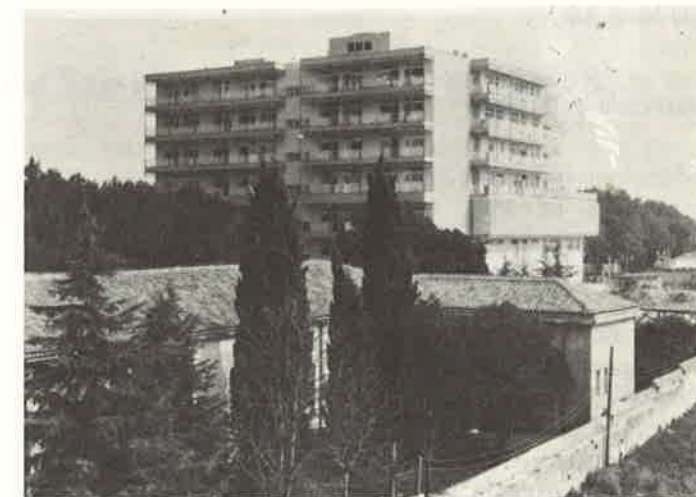
Slika 6. Nova zgrada Rodilišta i ginekologije Medicinskog centra u Puli otvorena 1979. godine. Na petom je katu smješten Dječji odjel
