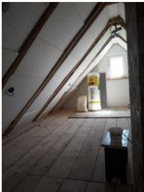
Slika 7. Postavljanje zvučne izolacije na zidove-stiropor i staklena vuna.
