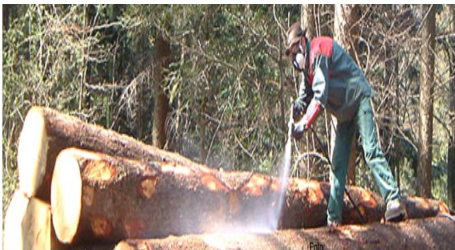
Slika 11. Nanošenje insekticida metodom prskanja (izvor: [3])
