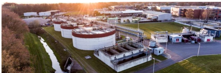
Slika 1. Prikaz postrojenja za obradu komunalnih otpadnih voda (10)
