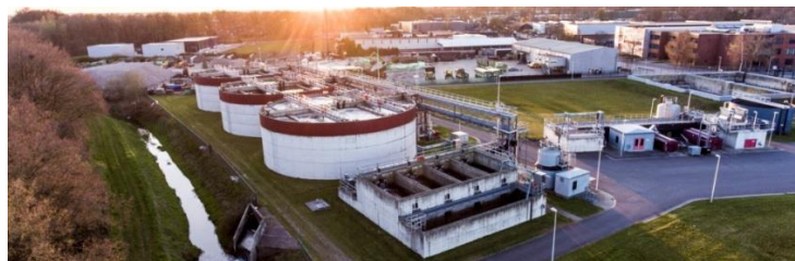
Slika 1. Prikaz postrojenja za obradu komunalnih otpadnih voda (10)
