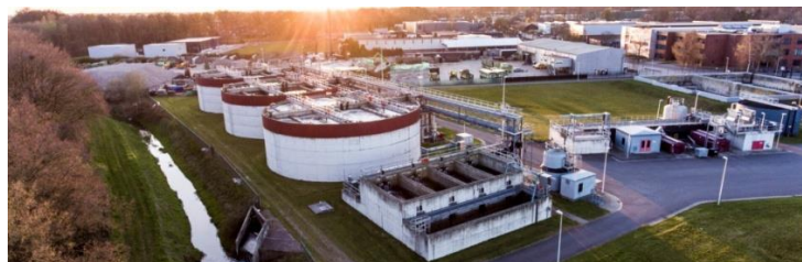
Slika 1. Prikaz postrojenja za obradu komunalnih otpadnih voda (10)
