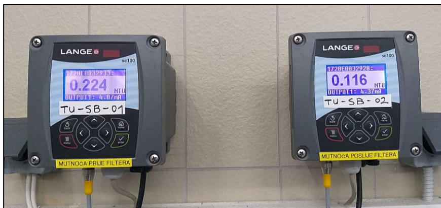
Slika 17. Uređaj za očitavanje mutnoće (turbidimetar) vode prije i poslije filtriranja vode
