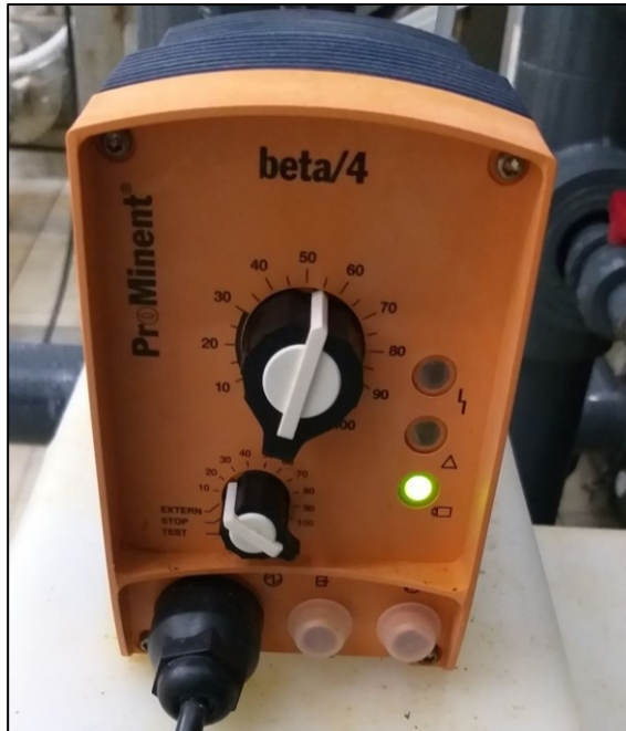
Slika 21. Uređaj za regulaciju veličina kapljica i frekvencije ispuštanja NaOCl
