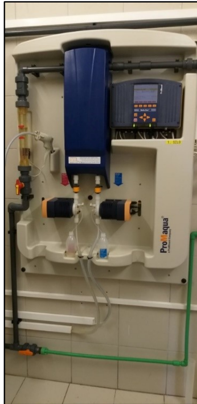
Slika 10. Uredaj za dezinfekciju klor dioksidom
