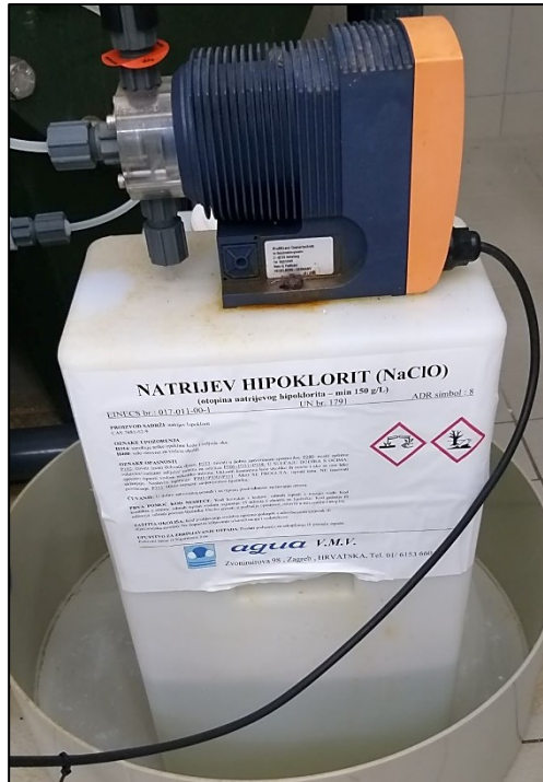
Slika 20. Uređaj za dezinfekciju s NaOCl
