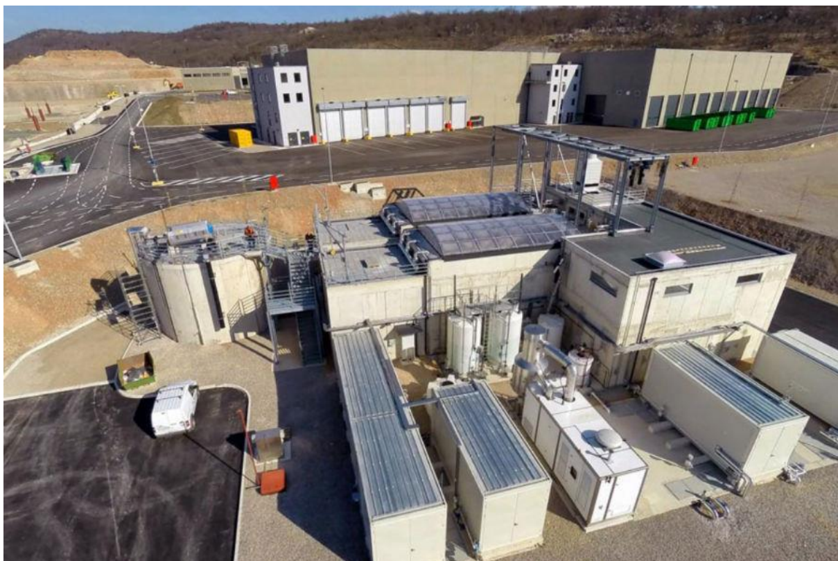
Slika 8. Odlagalište otpada Marišćina
