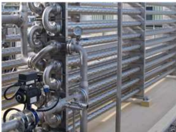
Slika 6.9. Izgled cjevastog izmjenjivača topline u industrijskoj izvedbi (9)
