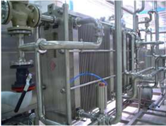
Slika 6.10. Izgled pločastog izmjenjivača topline u industrijskoj izvedbi
