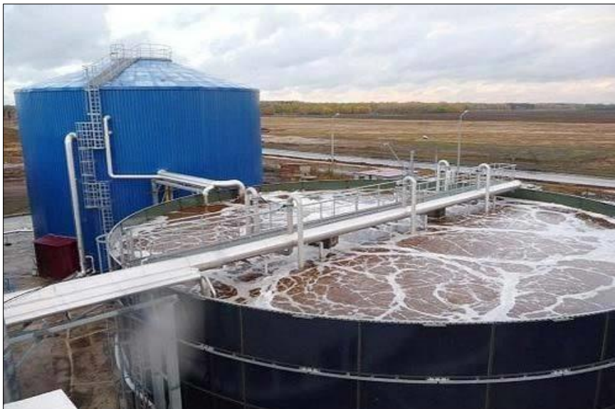
Slika 6. Prikaz spremnika za biološku obradu otpadnih voda [26]
