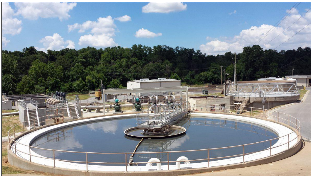
Slika 5. Prikaz spremnika u kojem se odvija primarni proces obrade otpadnih voda [24]
