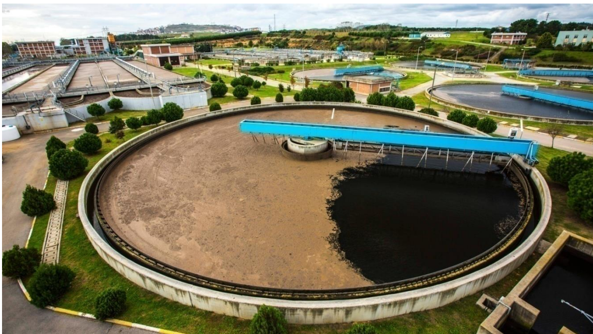
Slika 2. Prikaz spremnika za biološku obradu otpadnih voda
