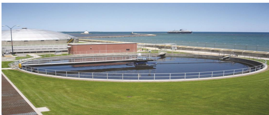
Slika 1. Prikaz spremnika za primarni proces obrade otpadnih voda
