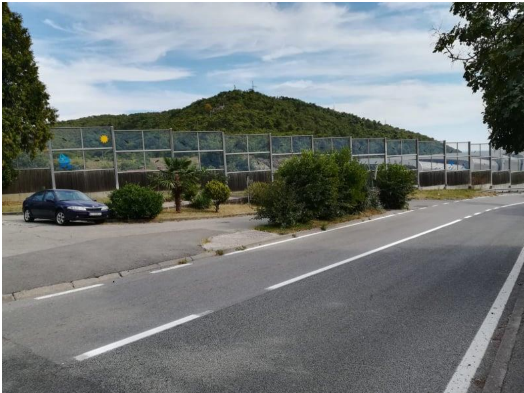
Slika 8. Reflektirajuće apsorbirajući bukobran uz autocestu Zagreb-Rijeka na ulazu u grad Rijeku.
