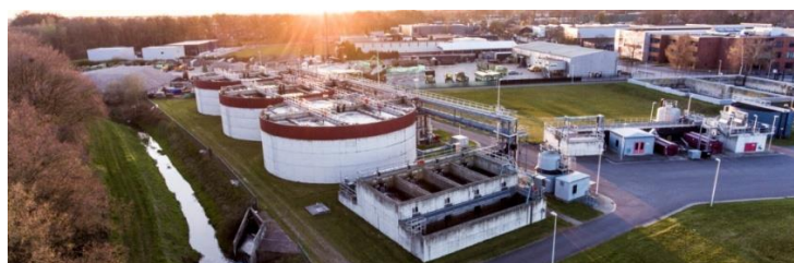
Slika 1. Prikaz postrojenja za obradu komunalnih otpadnih voda (10)
