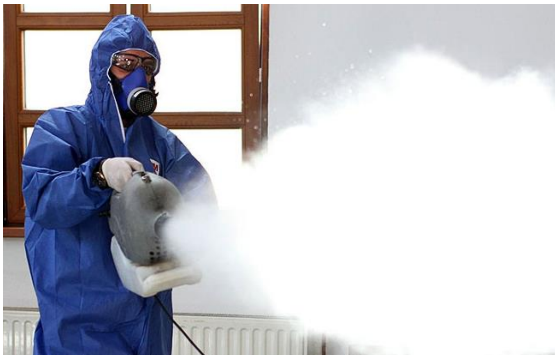
Slika 7. Prikaz postupka aerosolizacije kao kemijske dezinfekcije prostora suspektno zaraženih COVID-19 [49]
