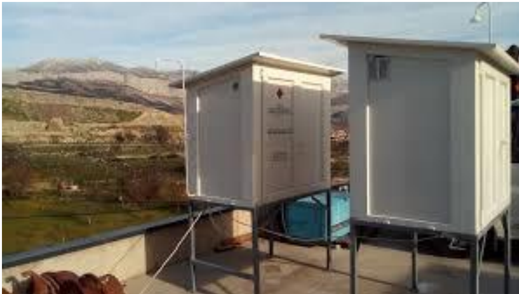
Slika 10. Automatska mjerna postaja Karepovac, na terasi privatnog objekta.
