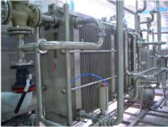
Slika 6.10. Izgled pločastog izmjenjivača topline u industrijskoj izvedbi
