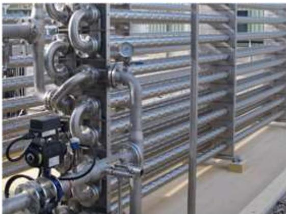
Slika 6.9. Izgled cjevastog izmjenjivača topline u industrijskoj izvedbi (9)
