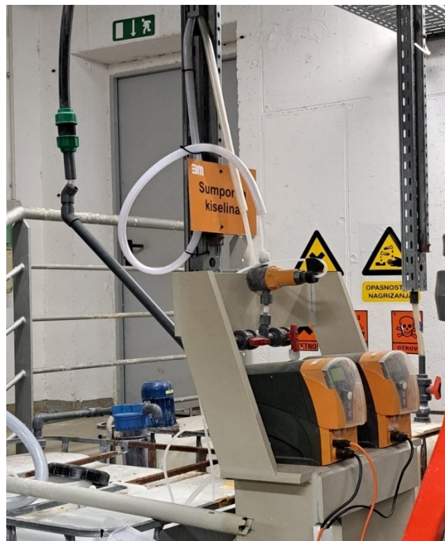
Slika 3. Uređaj za doziranje sumporne kiselina Izvor: privatna kolekcija
