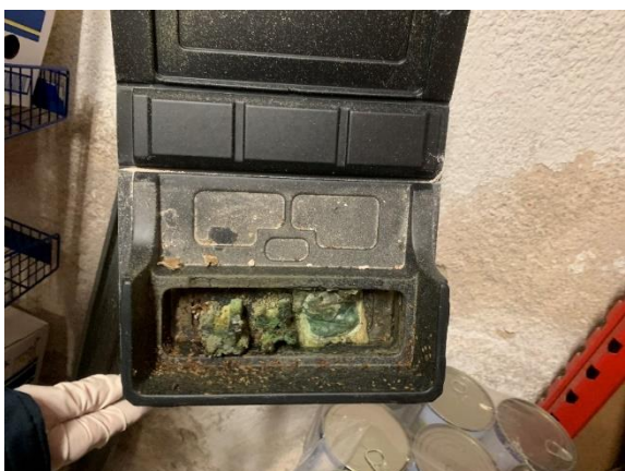
Slika 24. Oštećeni mamci unutar deratizacijske kutije
