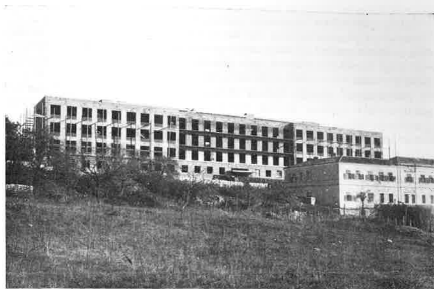
Glavna zgrada Kliničke bolnice »Dr Zdravko Kučić« u izgradnji (1933. god.)
