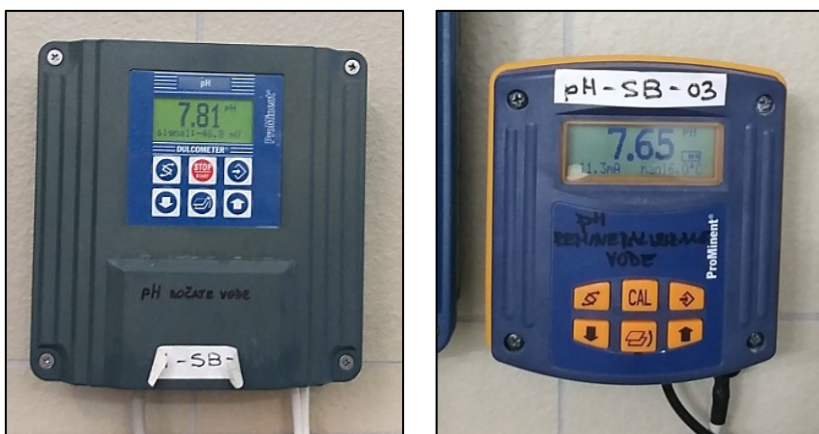
Slika 18. Uređaj za očitavanje pH vode prije i poslije desalinizacije
