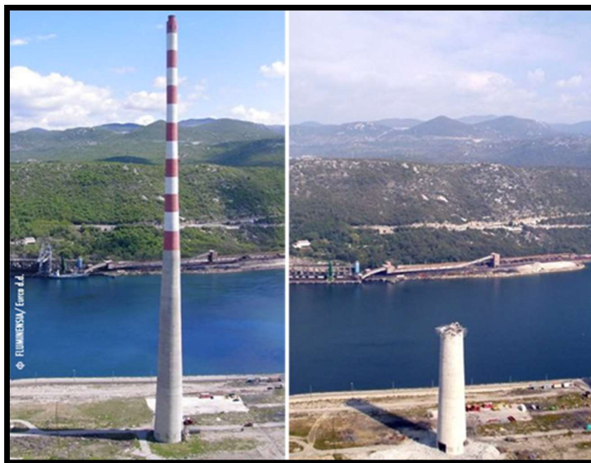
Slika 9 Prikaz dimnjaka visine 250 metara u Bakru i ostaci nakon početka rušenja. Izvor: www.fluminensia.org
