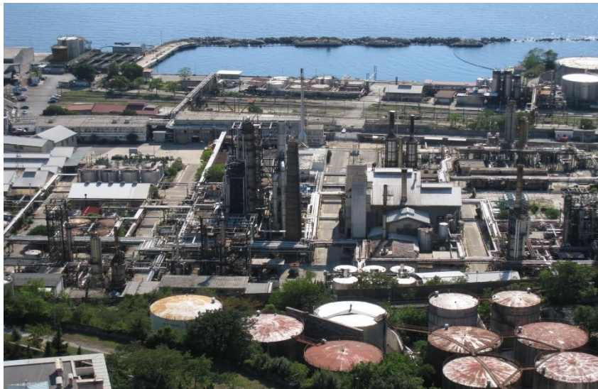
Slika 1.: Postrojenje Rafinerije INA Mlaka (Slika preuzeta sa: http://www.lokalpatriotirijeka.com/forum/viewtopic.php?f=20&t=1040&start=15 )
