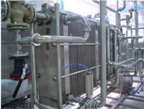
Slika 6.10. Izgled pločastog izmjenjivača topline u industrijskoj izvedbi
