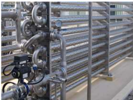
Slika 6.9. Izgled cjevastog izmjenjivača topline u industrijskoj izvedbi (9)
