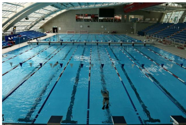
Slika 3. Olimpijski bazen (Izvor: http://www.bloglasnik.net/veliki-gradovi/rijeka/besplatan-ulaz-na-bazene-kantrida-za-sve-gradane-tijekom-listopada/ )
